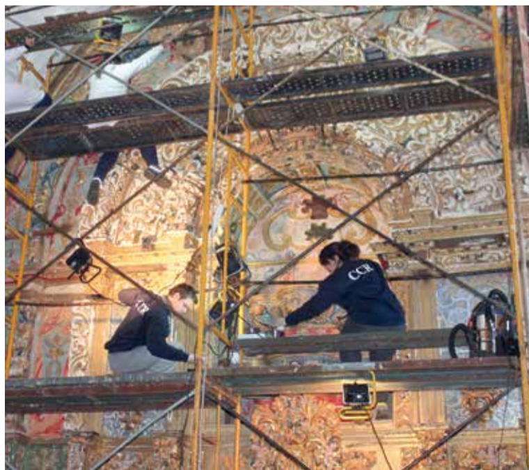
● Obra de restauro em Cércio, Miranda do Douro
